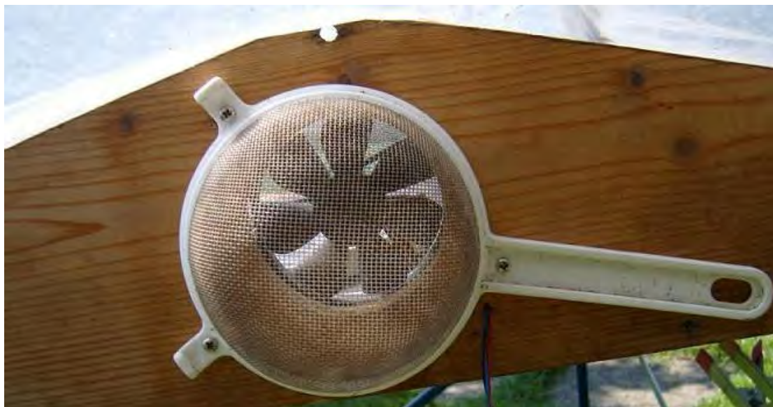
Fig 10 : Abdeckung des Ventilators
