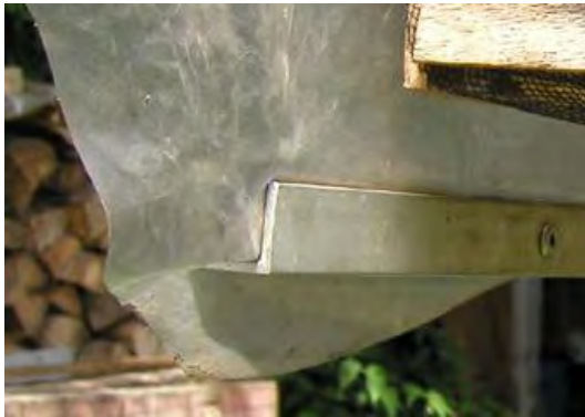
Fig 8 : Winkelprofil auf der Unterseite
